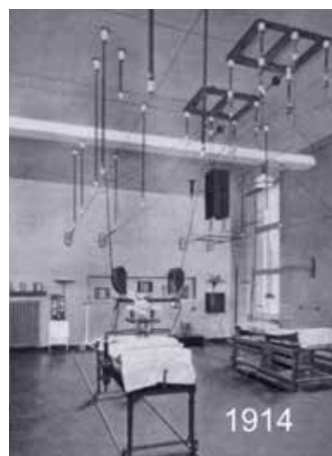
Figuur 2. Twee voorbeelden van de ongeïsoleerde bedrading van röntgentoestellen. Links röntgenkamer van Albers-Schönberg in Hamburg. Rechts een Victor-systeem met Coolidgebuis (foto uit collectie van dr. D.O. Cuscela).
