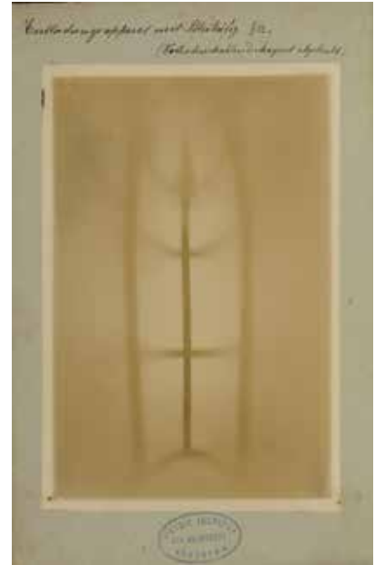
Figuur 8. Röntgenfoto's van een lodenkooi die zich om de gasontladingsbuis bevond, waarbij eerst de kathodestralen niet zijn afgebogen (A) en daarna, met behulp van een magneet, wel (B). Het resultaat is dat de kathodestralen op een andere plek terecht komen en dus de bron van de röntgenstralen zich verplaatst met een verplaatsing van de schaduwen van de loden spijlen van de kooi als gevolg. Röntgen heeft hieruit kunnen afleiden dat de röntgenstralen ontstaan op de plek waar de kathodestralen de glaswand van de gasontladingsbuis treffen en dat er een essentieel verschil is tussen kathodestralen en röntgenstralen, omdat de eerste kunnen worden afgebogen en de laatste niet.
